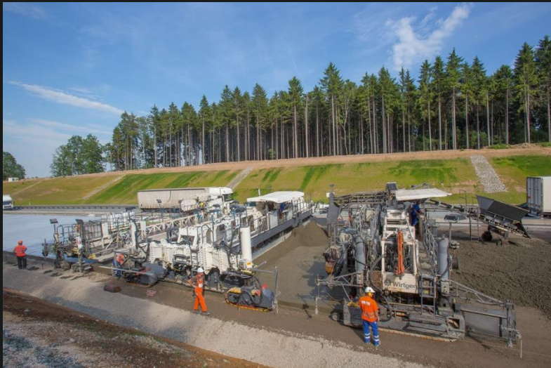
Einbau mit Fertigern
