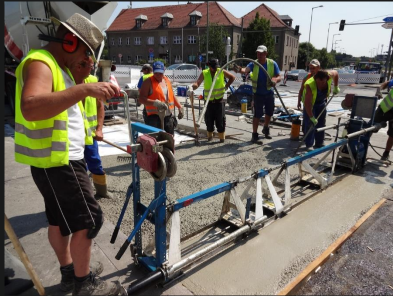
Einbau mit handgeführter Einbaubohle
