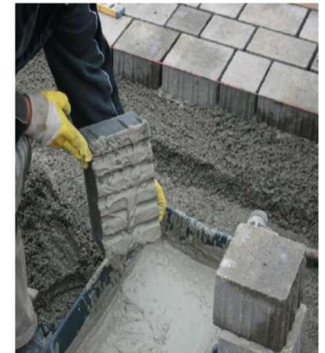
Die profilierte Unterseite bei LP 5 sorgt für erhöhte Haftzugfestigkeit.
