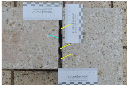
Verfüllbare Fuge über den Fugenquerschnitt bei hinreichender Fugenbreite zwischen den Abstandshilfen.
