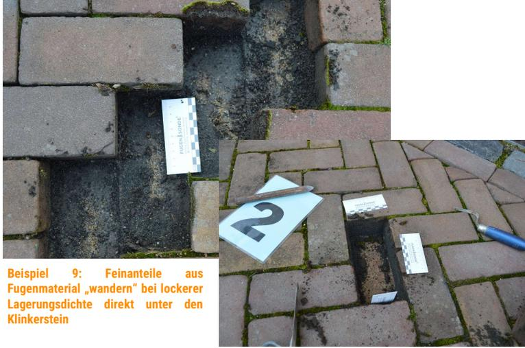
**Beispiel 9:** Feinanteile aus Fugenmaterial „wandern“ bei lockerer Lagerungsdichte direkt unter den Klinkerstein
