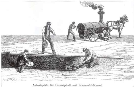
Arbeitsplatz für Gussasphalt mit Locomobil-Kessel.
